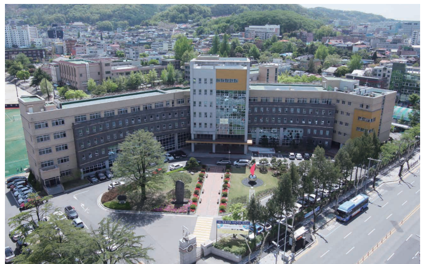
2018. 4. 25. 대전고 교사 전경 - 조형물 설치, 한모동산 리모델링한 모습
